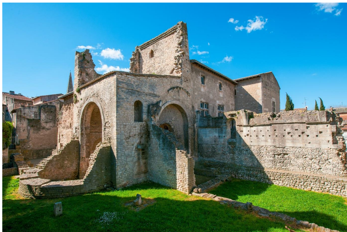
Hôtel de Sade © Centre des monuments nationaux
